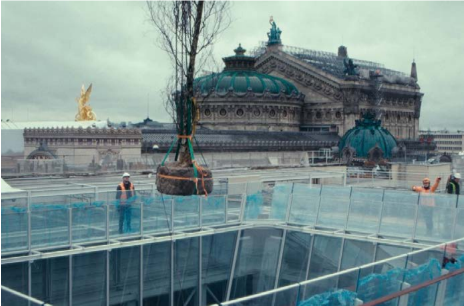
컨스트럭션 사이트 Construction Site
